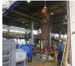
(発電機分解点検作業)
