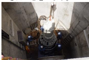
(水車発電機据付作業)
