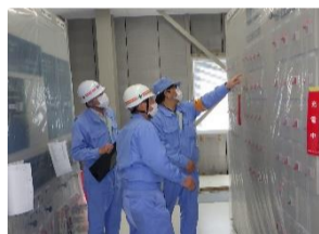
(福井開閉所安全パトロール)
