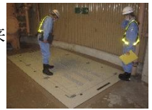
(音沢発電所開口部)
